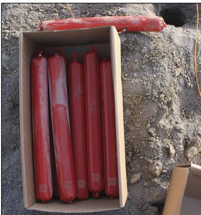
Abb. 1: Karton mit Sprengstoff
